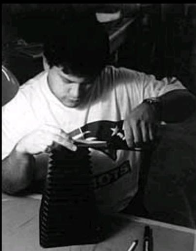
Alla Wisner gran parte delle operazioni avviene ancora manualmente. Qui un operaio effettua la pieghettatura del soffierto prima del montaggio.
