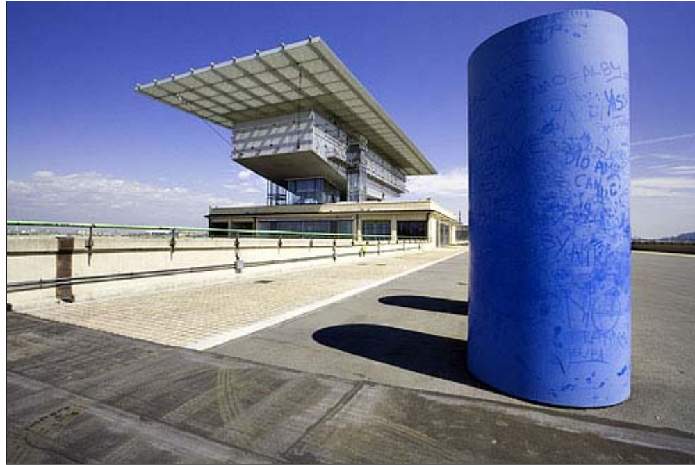
La struttura per l'atterraggio degli elicotteri. I cilindri di colore azzurro sono stati voluti dall'architetto Renzo Piano per ricordare i fumaioli di una grande nave, idea suggerita dalla forma stessa della pista di collaudo.
